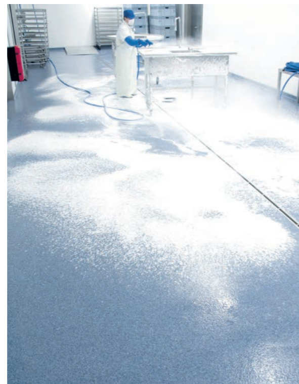
Die rutschhemmenden Silikal-Reaktionsharzböden lassen sich schnell verlegen, sind einfach zu reinigen und hygienisch sauber. (Bild: Silikal) The slip resistant Silikal reaction resin floors are quick to install, easy to clean and hygienically clean. (Image: Silikal)
