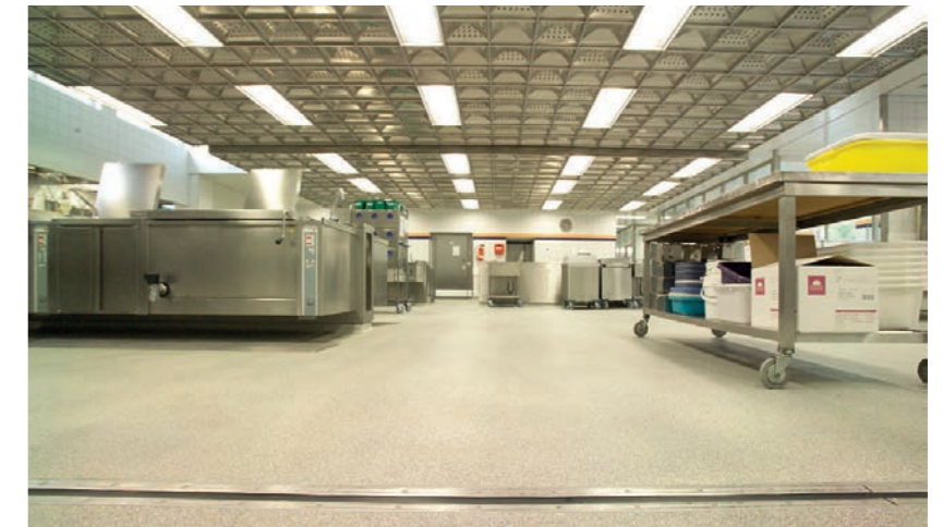
Für besonders eilige Umsetzung kann auf schnellhärtende Systeme zurückgegriffen werden. (Bild: Fürstnhöfer) For particularly urgent implementation, fast-curing systems can be used. (Image: Fürstnhöfer)
