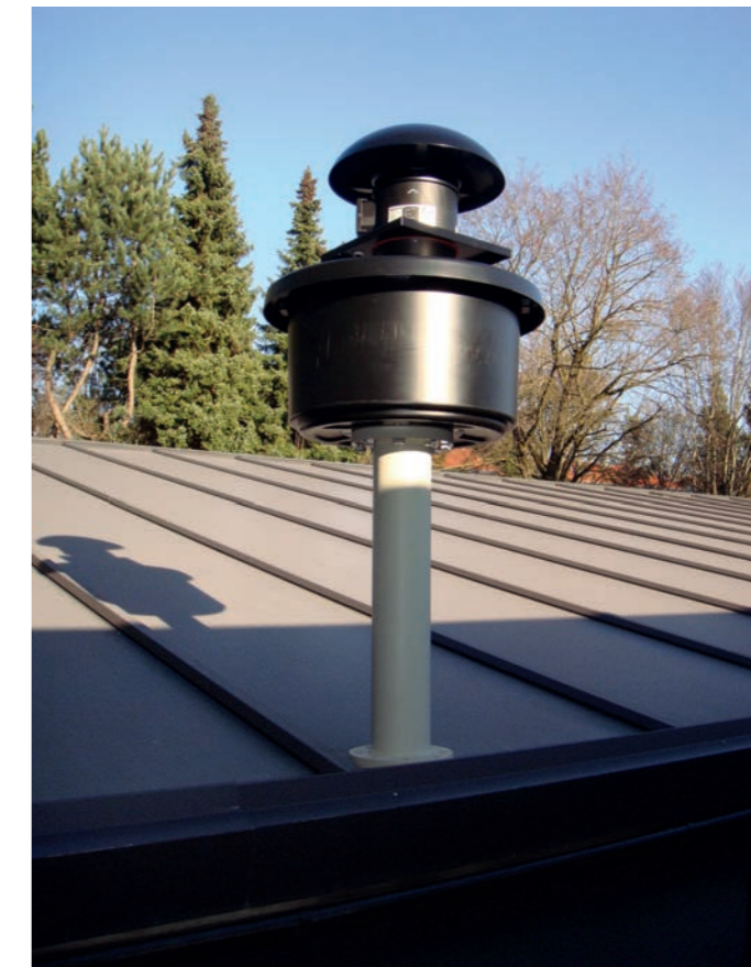
Auch die kleinen Coalsi-Mehrfachkammerfilter an der Auslassöffnung des Abluftrohrs neutralisieren geruchsbildende Stoffe, bevor diese in der Umgebung auffällig werden. The small Coalsi multi-chamber filters at the outlet of the exhaust air pipe neutralize odour-forming substances before they become noticeable in the environment.
