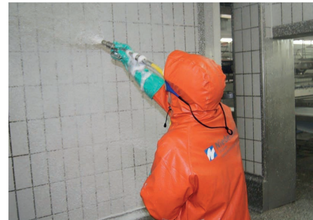
Arbeitsflächen, Wände, Decken, Böden und Fliesen werden in der Regel manuell unter Zugabe eines Schaumreinigers gesäubert. (Bilder: Niederberger) Work surfaces, walls, ceilings, floors and tiles are usually cleaned manually with the addition of a foam cleaner. (Images: Niederberger)
